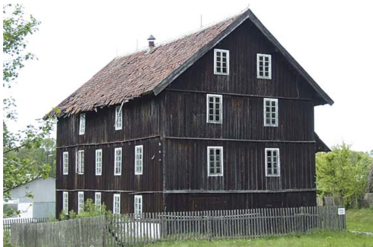
Il. 6. Budynek młyna w Rusi, gm. Stawiguda, fot. Archiwum MBL-PE w Olsztynku, stan z 2009 r.
