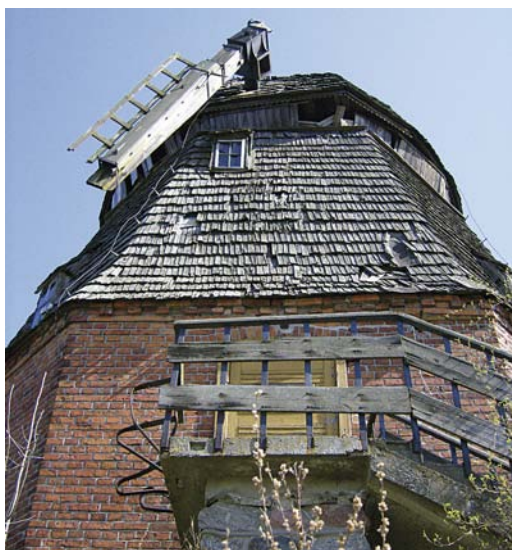
Il. 4. Wiatrak w Bęsi gm. Kolno, fot. Archiwum MBL-PE w Olsztynku, stan z 2008 r.
