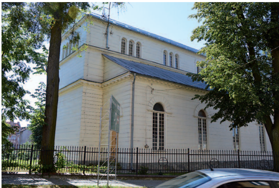
Il. 22. Lidzbark Warmiński, dawny kościół ewangelicki, obecnie cerkiew, widok po remoncie elewacji, 2015, W. Chodkowska 2015.
