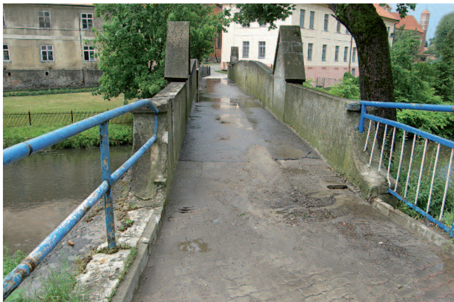
Il. 17. Widok mostu/kładki od strony południowej, fot. W. Chodkowska 2016.
