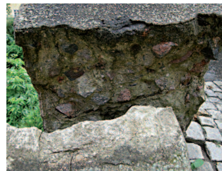
Il. 19. Przekrój ściany oporowej, fot. W. Chodkowska 2016.
