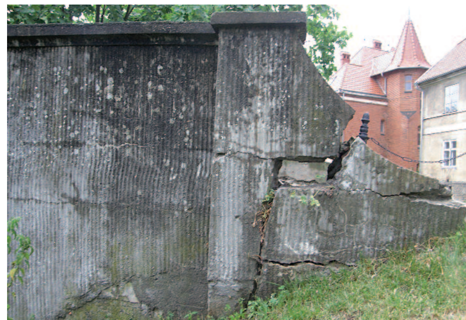
Il. 15. Ściana oporowa od strony wschodniej, wypełniająca przestrzeń pomiędzy przyczółkiem a skarpą brzegu rzeki, fot. W. Chodkowska 2016.
