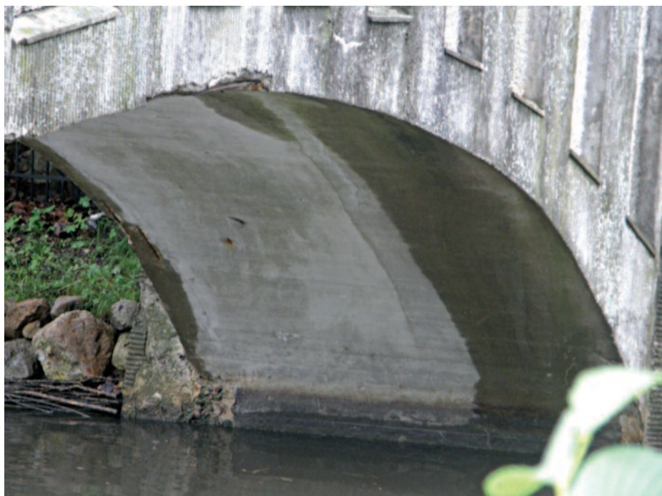
Il. 18. Podłucze mostu, fot. W. Chodkowska 2016.
