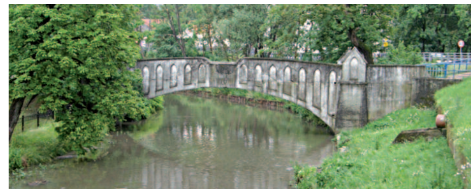
Il. 12. Lidzbark Warmiński, widok na most/kładkę im. Mikołaja Kopernika od strony zachodniej, fot. W. Chodkowska 2016.
