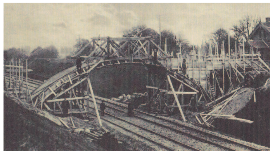
Il. 9. Sposób budowy pionierskiego łukowego wiaduktu na torze Chojnice-Tczew w roku 1906. Wykonawcą prac była firma Drenckhahn & Sudhop z Braunschweig, źródło: http://www.digbib.tu-bs.de/?docid=00030120 , dostęp: 3.07.2016 32 .
