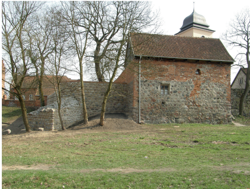
Il. 35. Olsztynek, widok na mur w sąsiedztwie baszty po pracach konserwatorskich, 2009, fot. W. Chodkowska.
