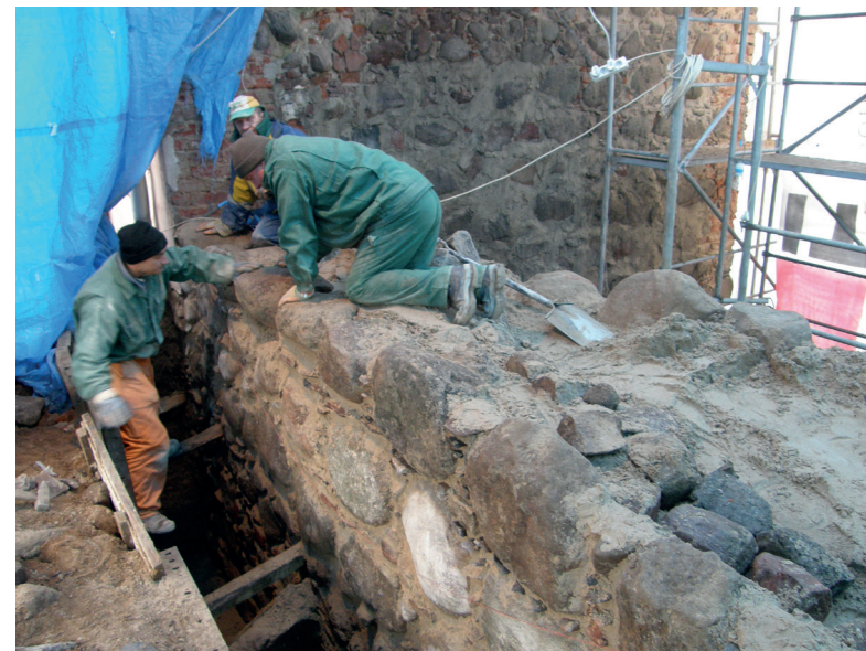
Il. 33. Olsztynek, prace konserwatorskie muru odsłoniętego w wykopie archeologicznym, 2008, fot. W. Chodkowska.
